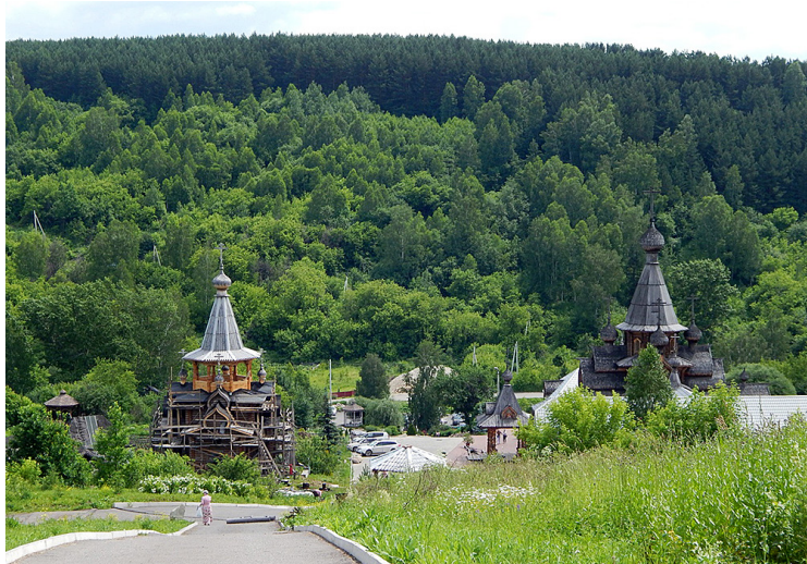
Ил. 2. Вид на строящуюся колокольню с подъёма на гору «Голгофа». Фото автора, 2019.
